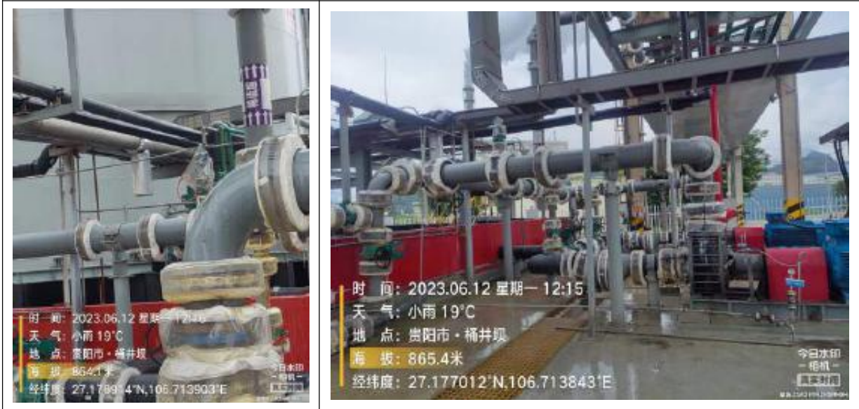
管道现场照片
