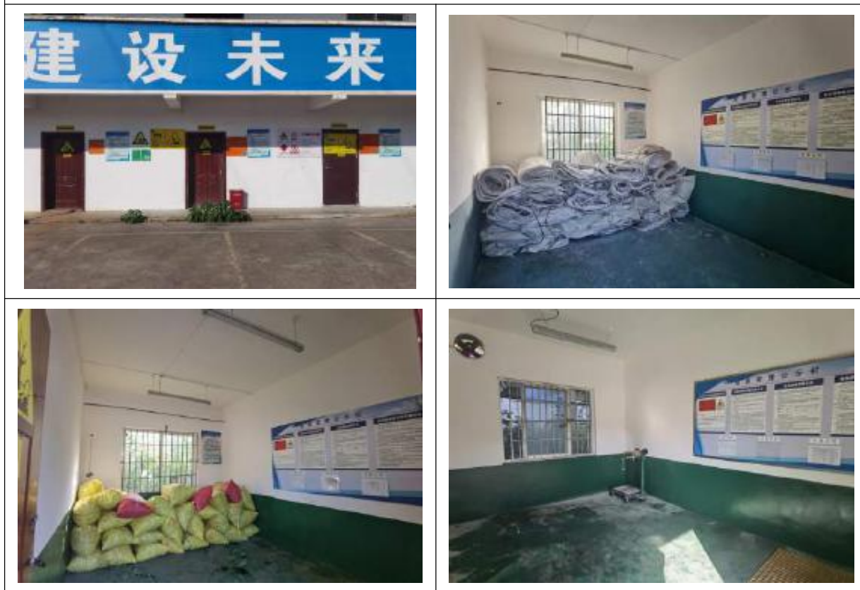
危废暂存间现场照片
